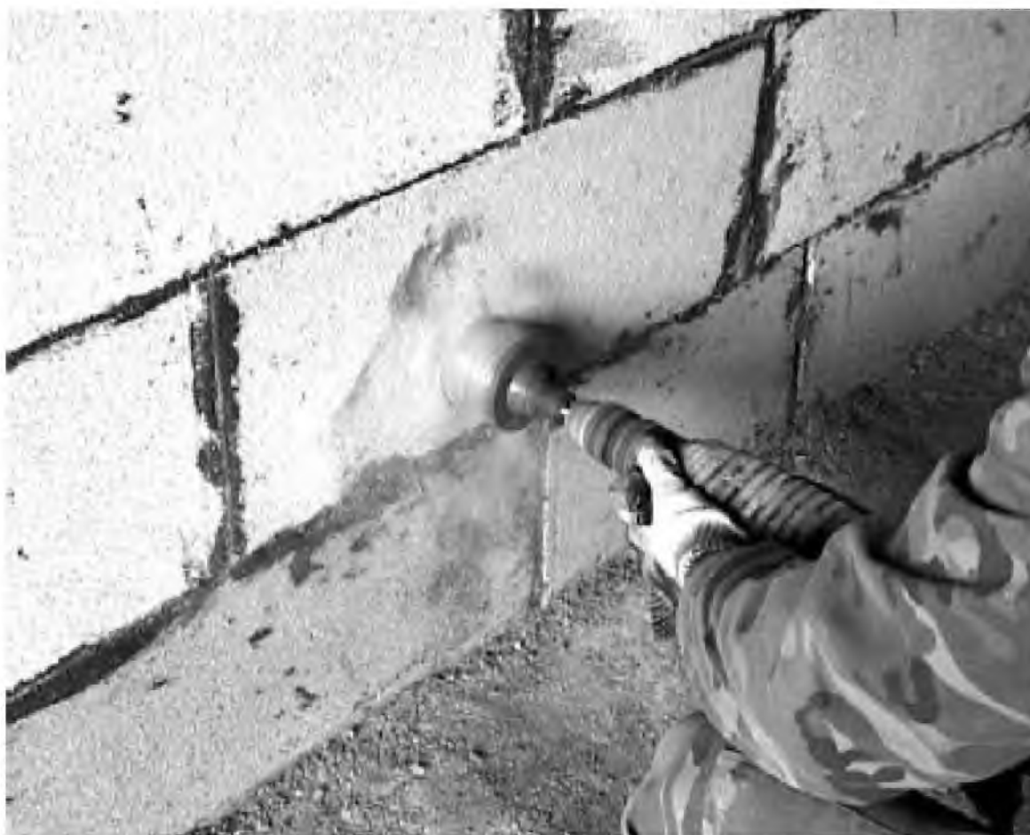
Рис. 5.18. Пример работы корончатой фрезой
