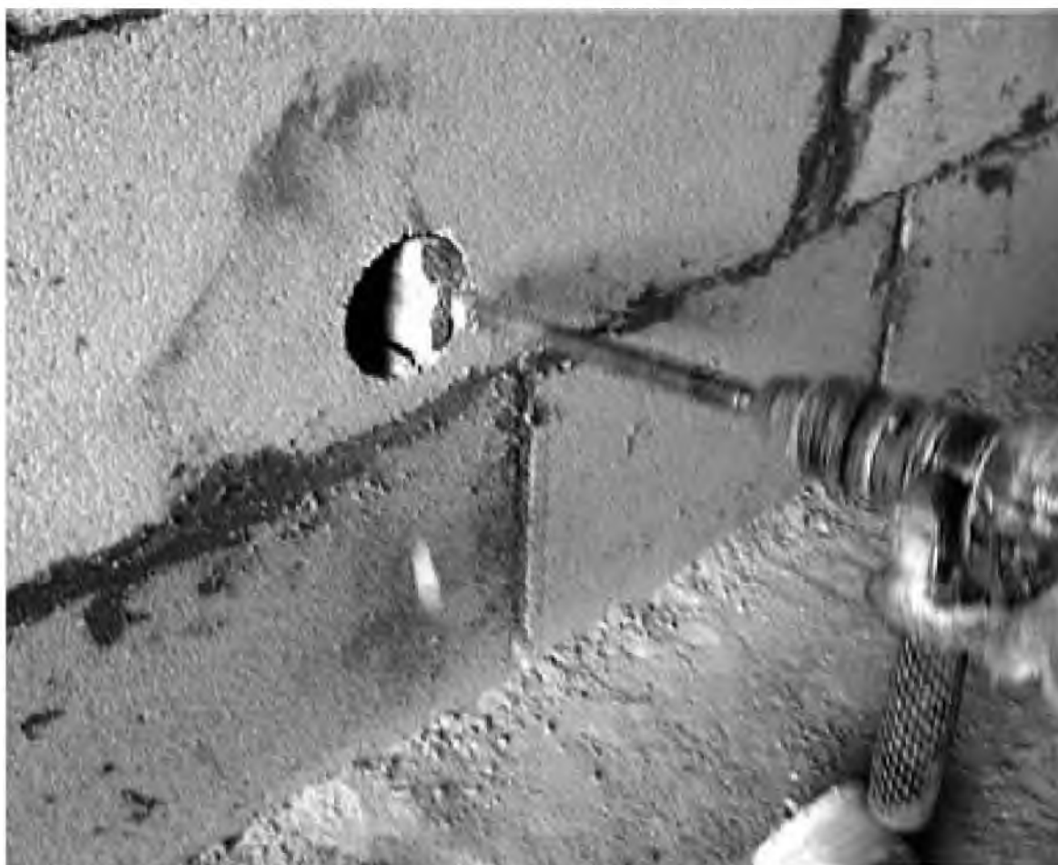
Рис. 5.20. Второй этап формирования круглого отверстия: удаление излишков стенового материала
