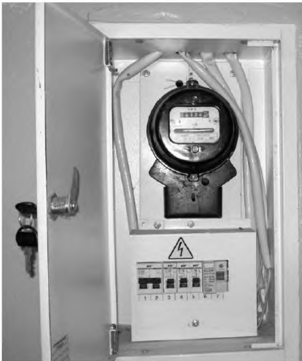
Рис. 1.17. Электрощит с однотарифным электросчетчиком с механическим отображением и обычной схемой снятия показаний
