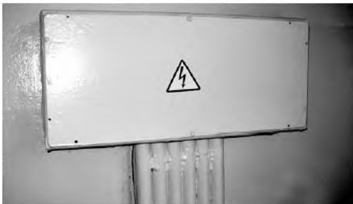
Рис. 3.8. Подвод кабеля в металлических трубах к вводно-распределительному устройству
