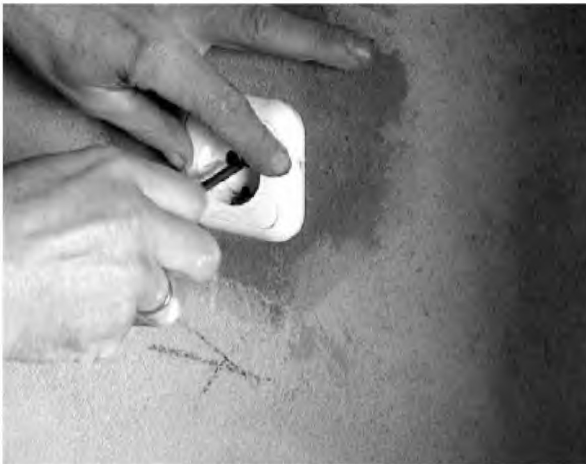
Рис. 1.12. Установка декоративной накладки
