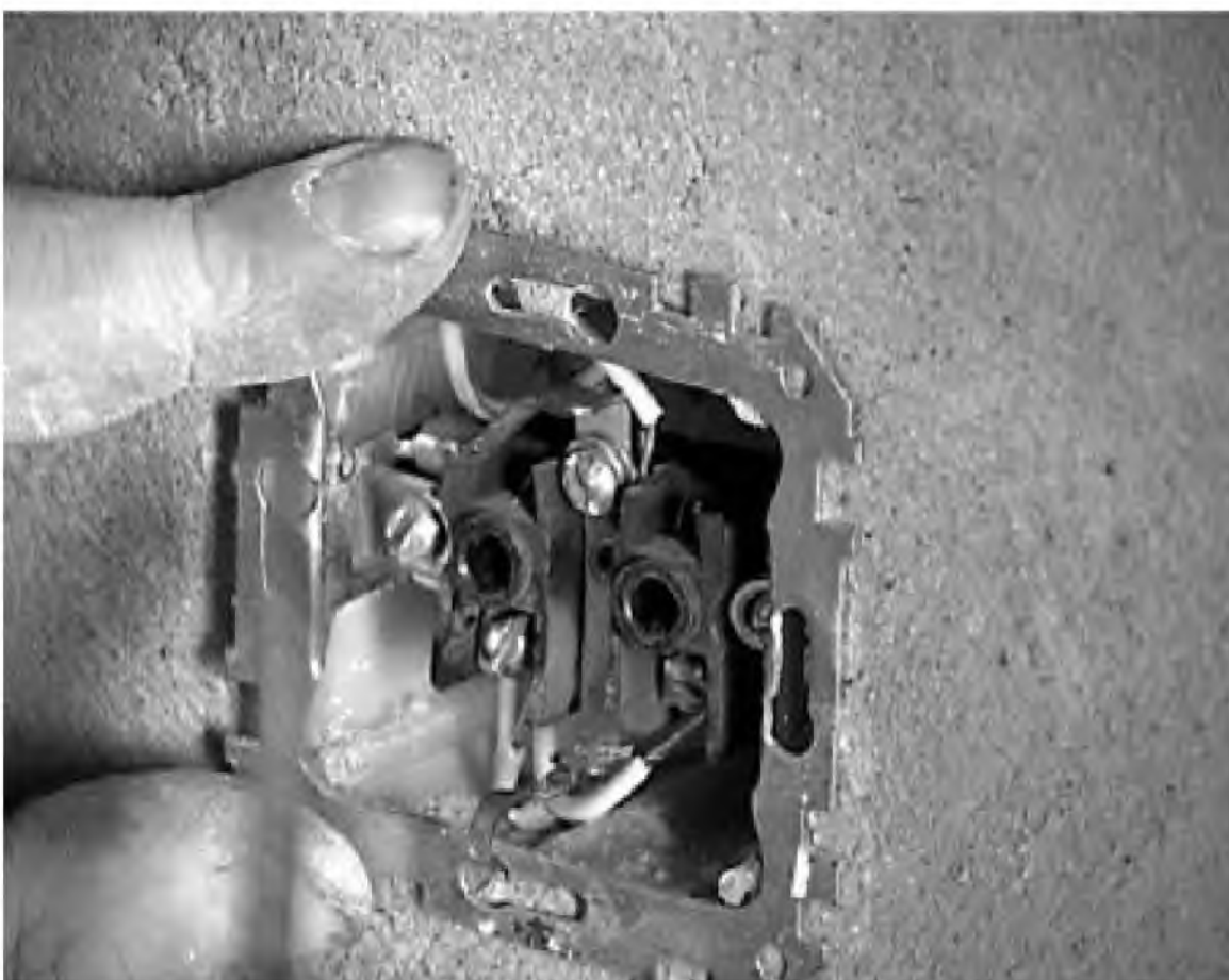
Рис. 1.11. Фиксация руками арматуры в коробке
