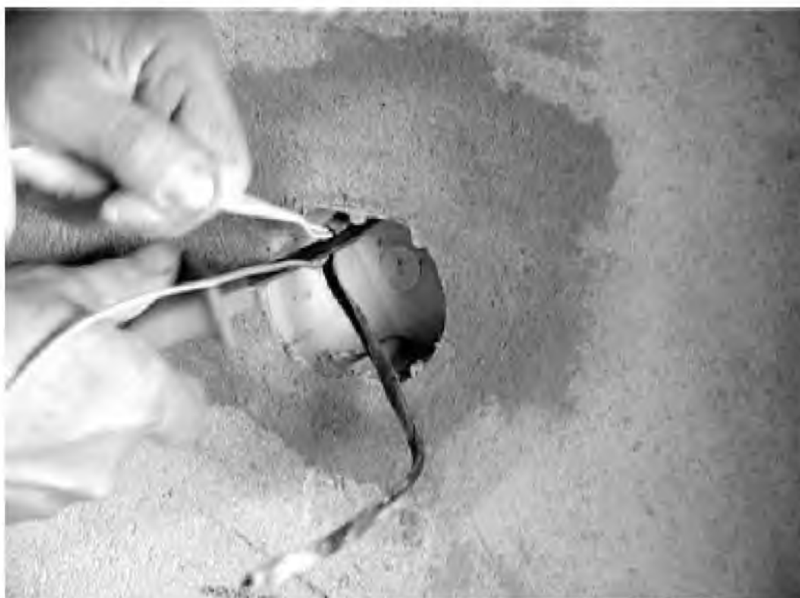
Рис. 3.5. Удаление изоляции с помощью монтажного ножа
