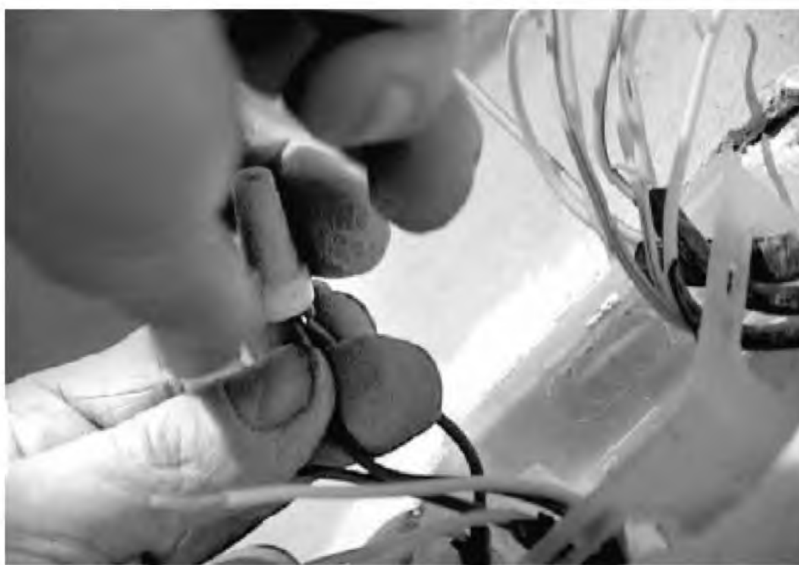
Рис. 1.4. Надеваем изоляционный колпачок на скрутку
