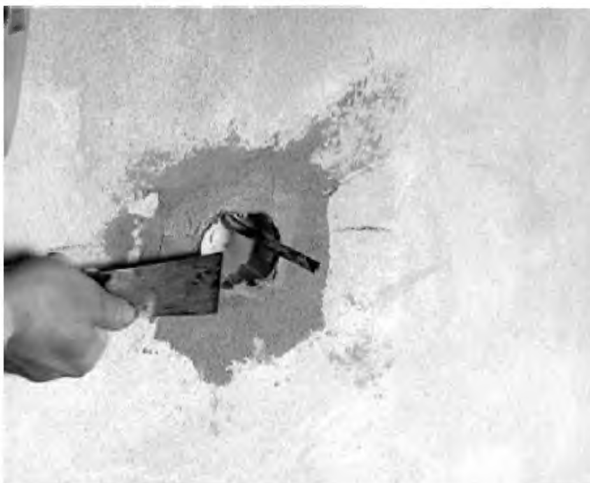
Рис. 1.7. Коробка электроустановочного изделия вмурована в стену
