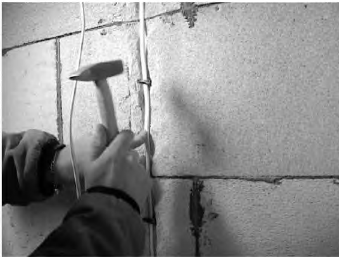
Рис. 1.15. Укладка провода в штробу
