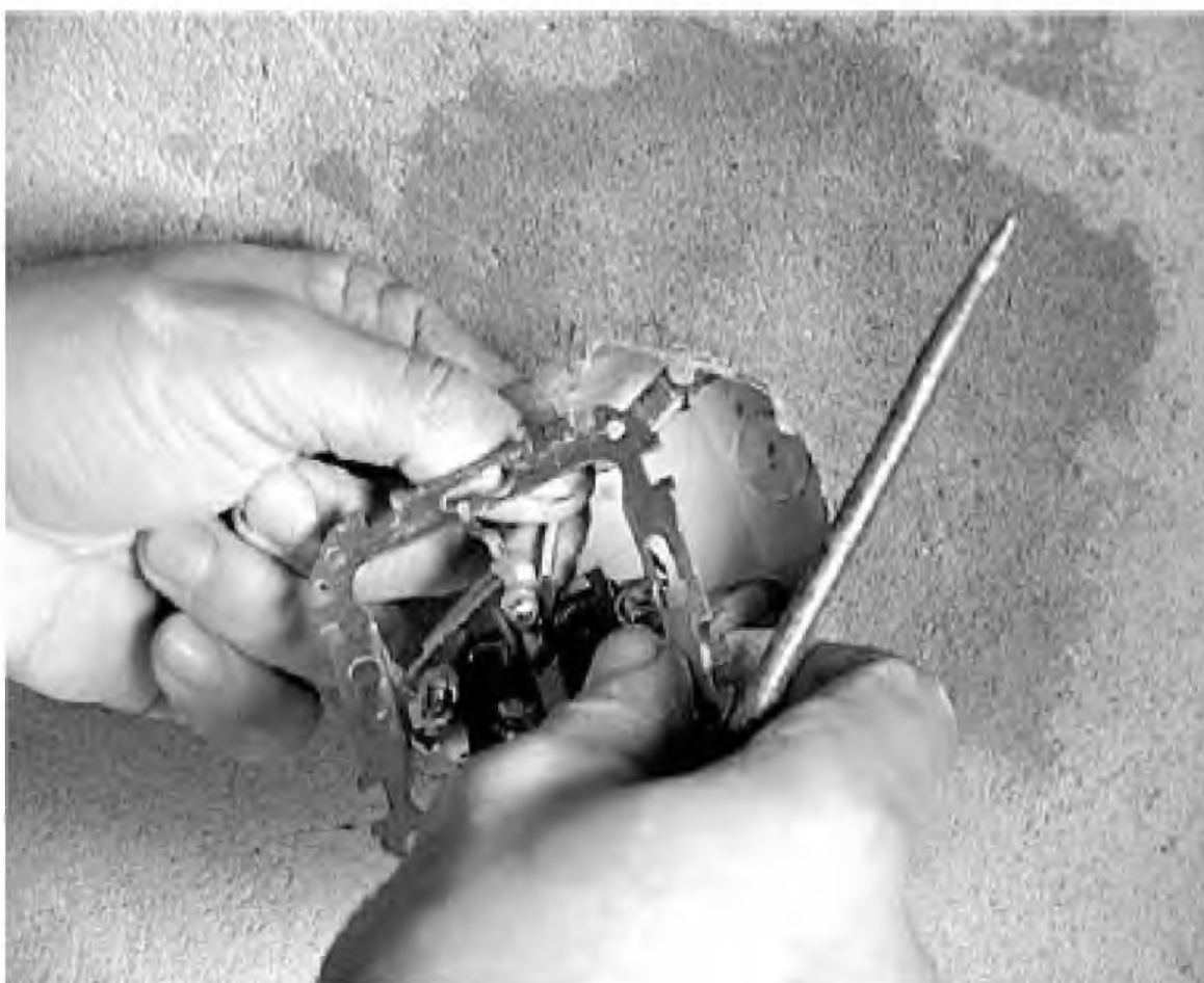
Рис. 1.9. Установка арматуры розетки
