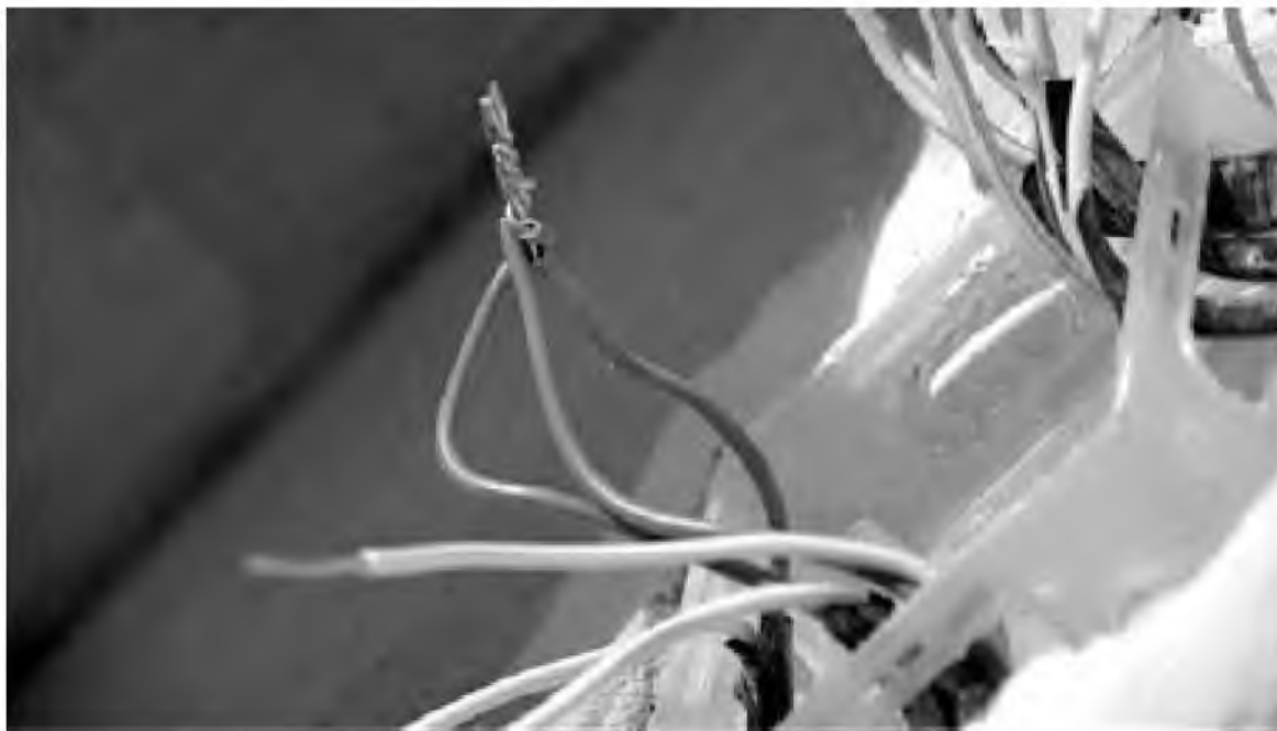
Рис. 1.3. Пример готовой скрутки
